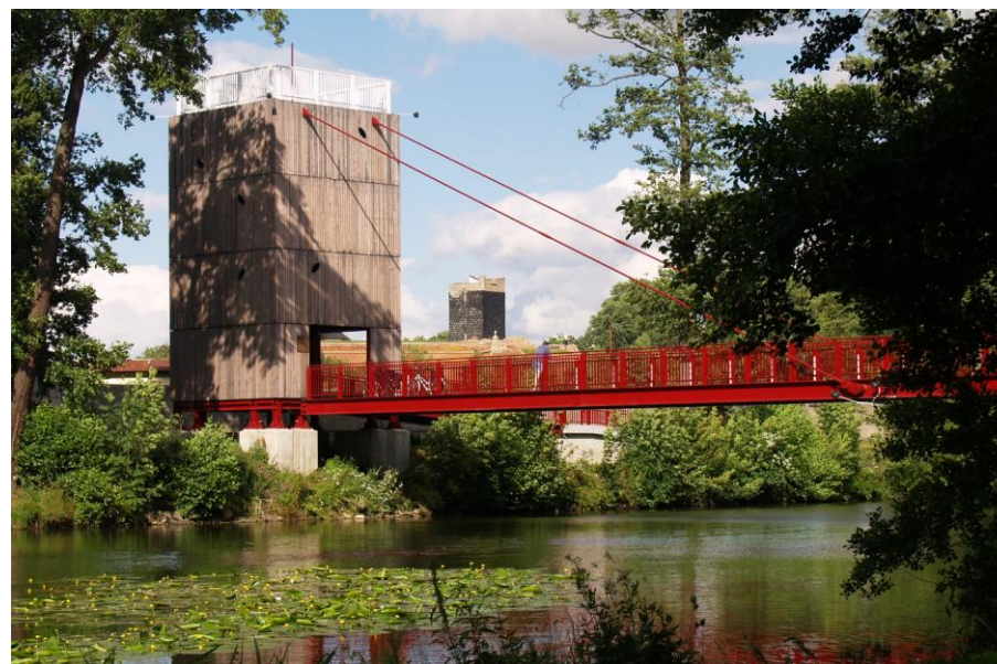
Vyhlídková věž Vávrova lávka na Ohři
